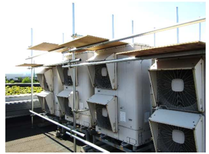
【室外機屋根の設置】
